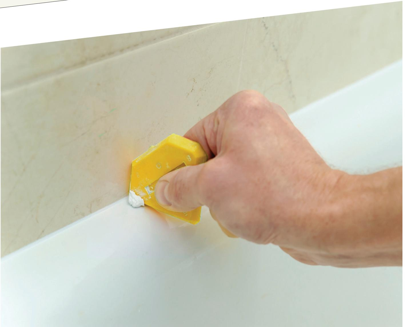
Bei der Verarbeitung von Fugen ist die Optik ein wesentlicher Aspekt für ein einwandfreies Ergebnis. Dafür eignen sich Glättmittel, die sich mit Hilfe von Glätthölzern oder Glättgummis auftragen lassen. Hierbei ist die Verträglichkeit des Glättmittels zum Dichtstoff sowie zum Untergrund sehr wichtig und sollte vom Hersteller des Dichtstoffes freigegeben und geprüft worden sein.
