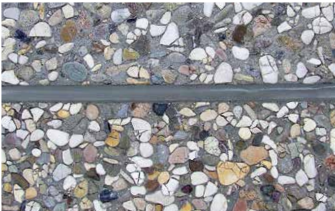
Begehbare Bodenfuge in Waschbetonfläche mit EGO SMP 805
