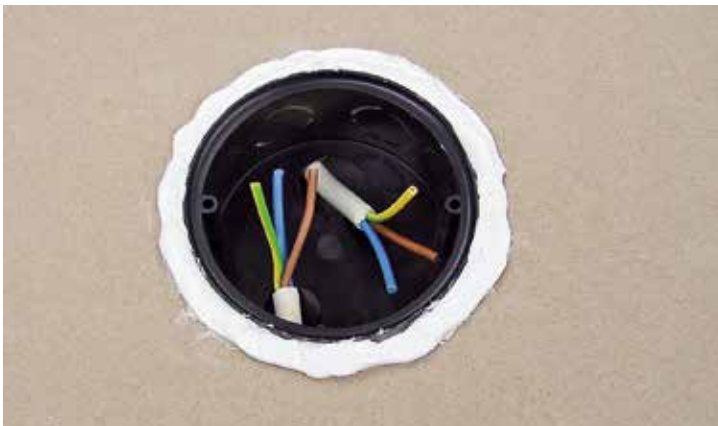
Befestigen von Elektro-Dosen mit EGO SMP 805 in Wandeinlässen
