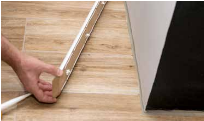
Kleben von Sockelleisten im Trocken- und Mauerwerksbau mit EGO SMP 805
