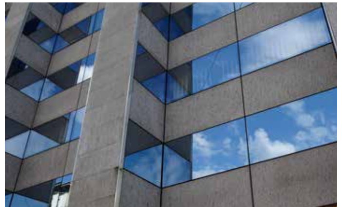
Hochbaufuge nach DIN 18540, abgedichtet mit EGO SMP 818
