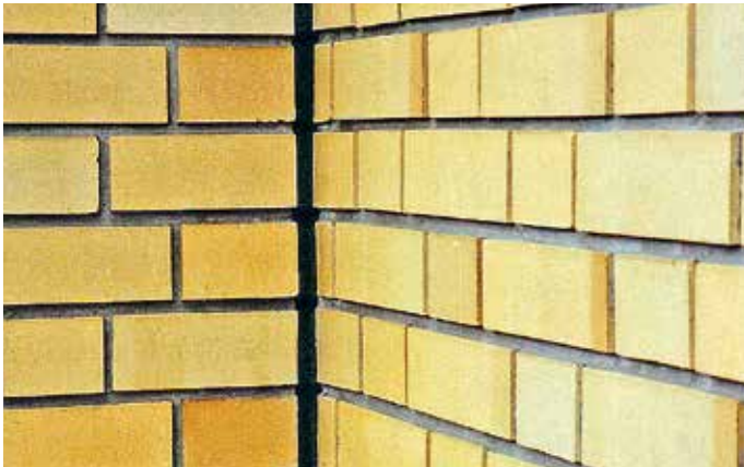
Hochbaufugen nach DIN 18540, abgedichtet mit EGO SMP 818 im Mauerwerksbau
