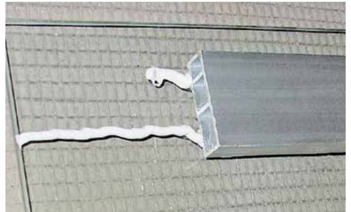
Kleben von Alu-Profilen auf Glas mit EGO SMP 822
