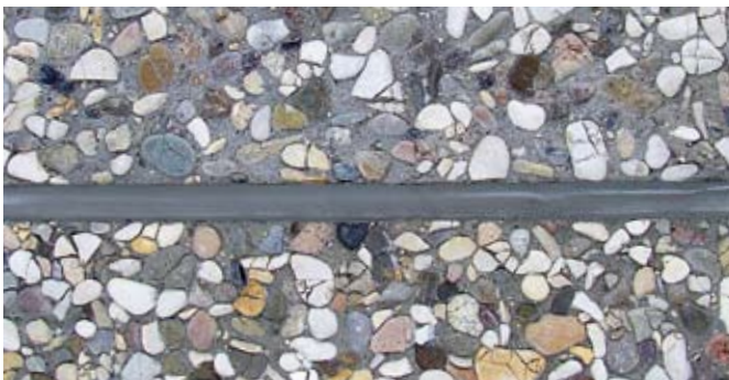
Begehbare Bodenfuge in Waschbetonfläche
