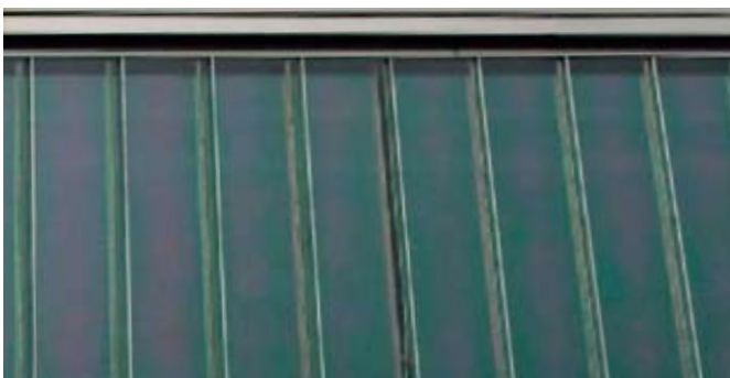
Versiegelung einer Profilit-Fassadenfläche
