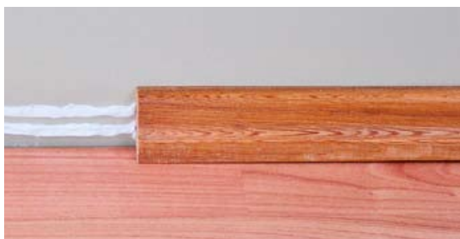
Kleben von Sockelleisten im Trocken- und Mauerwerksbau mit EGO MS 805
