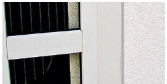
Fuge zwischen Baukörper und Hauseingang
