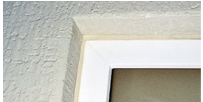
Fensteranschlussfugen außen mit EGO MS 801
