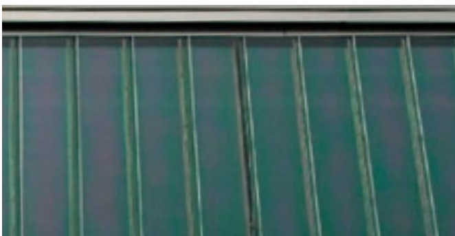
Versiegelung mit EGO MS 806 in Profilit-Fassade
