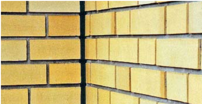
Hochaufugen nach DIN 18540, abgedichtet mit EGO MS 801 im Klinker-Mauerwerksbau
