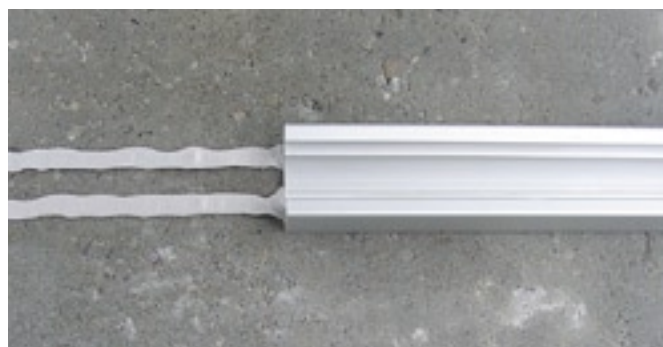
Kleben von Alu-Laufschienen auf Beton
