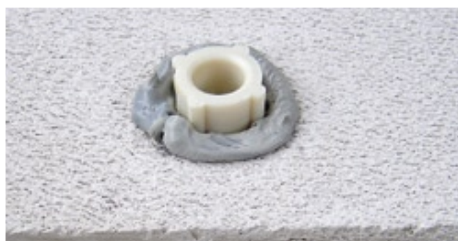
Einkleben von Großdübeln von EGO MS 805 in Porenbetonwand
