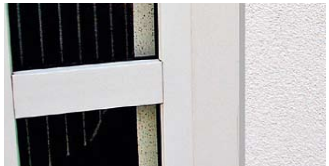
Fuge zwischen Baukörper und Hauseingang
