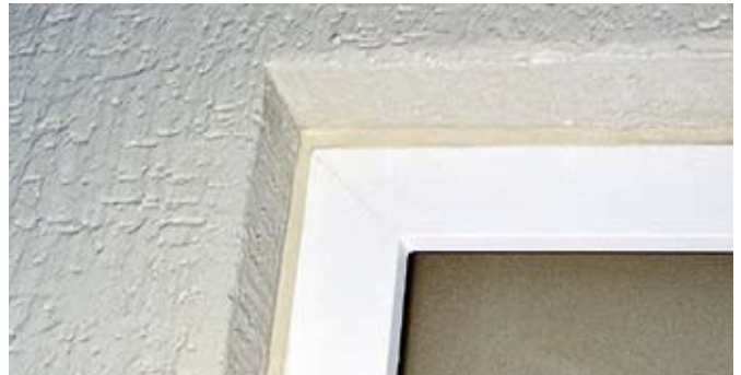
Fensteranschlussfugen außen mit EGO MS 801
