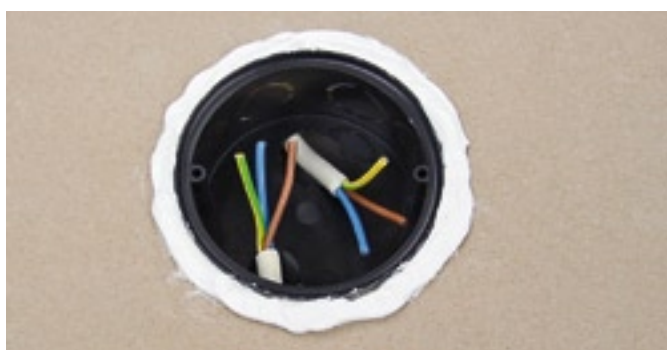
Befestigen von Elektro-Dosen mit EGO MS 805 in Wandeinlässen
